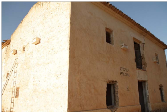
Figura 12. Caja nido instalada en Casa La Paloma (Villena)
