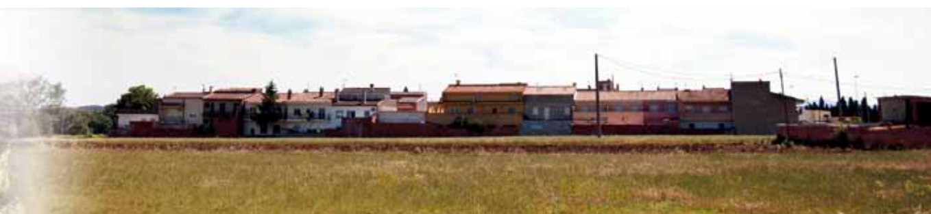
Vista de Santa Llogaia (Girona), donde se instalará la estación conversora del lado español.
