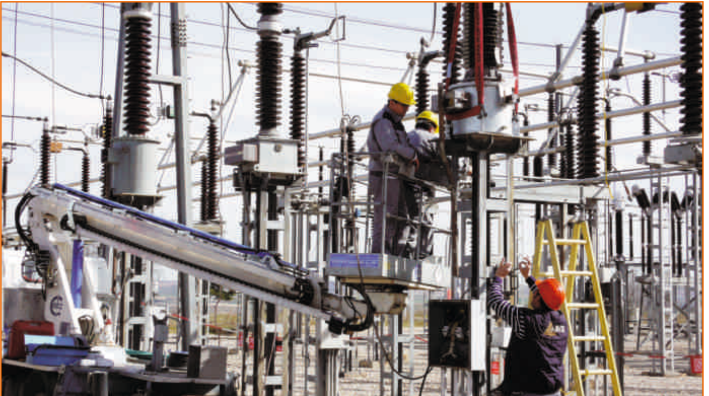
Inspección de un transformador de tensión de una subestación.
