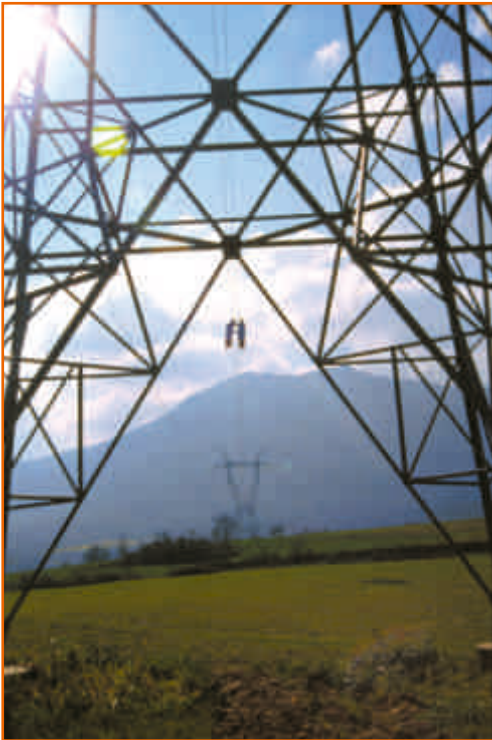
Operarios realizando trabajos de mantenimiento.
