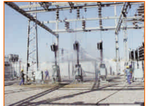
Limpieza en tensión de una subestación.
