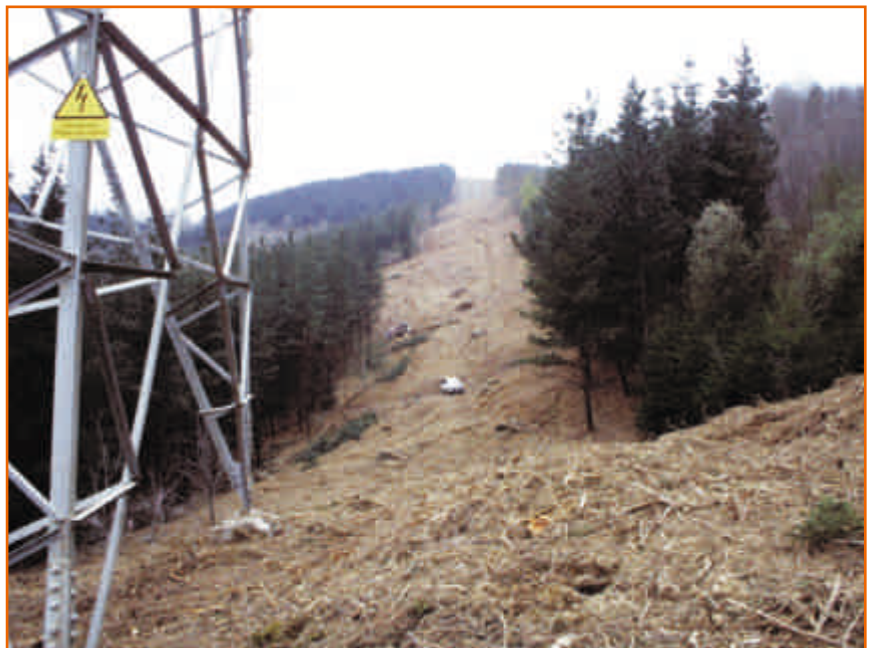
Estado de una línea tras los trabajos de tala y poda de la vegetación.
