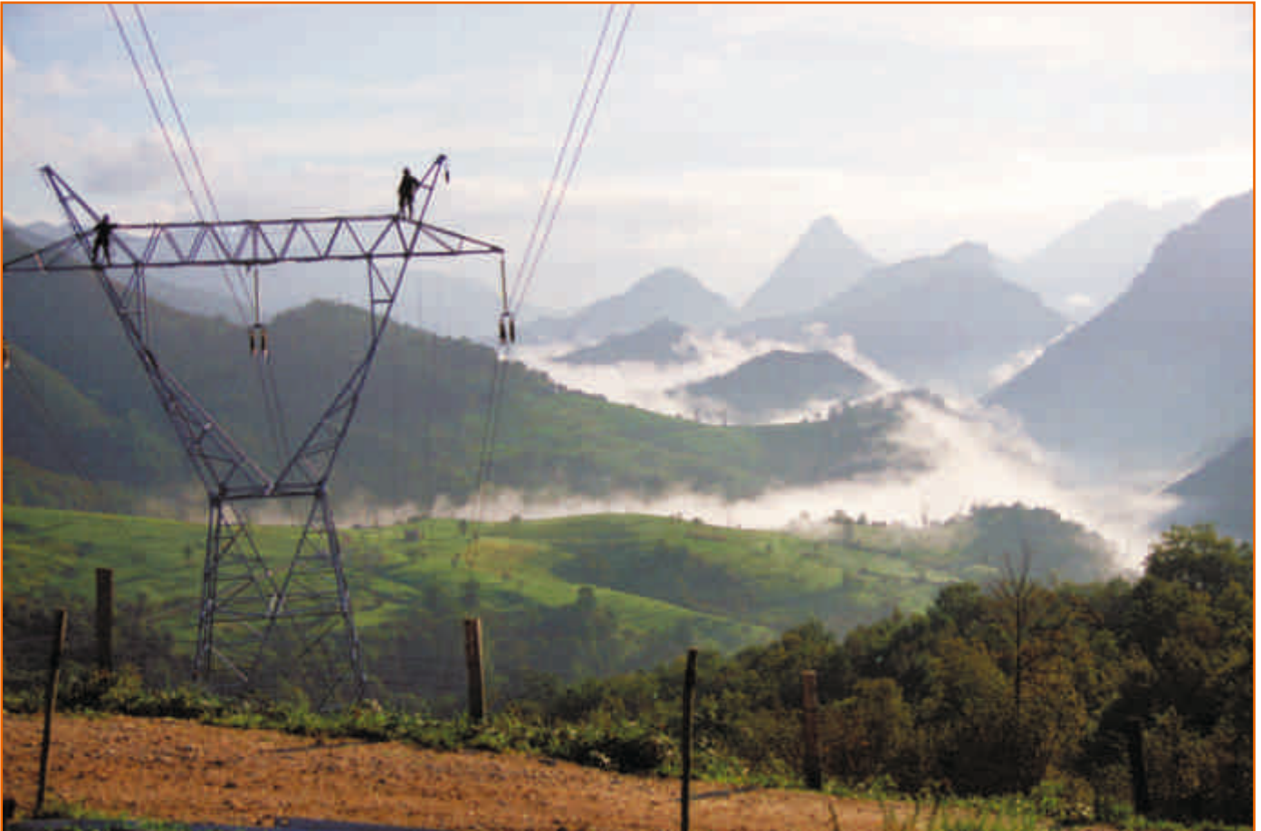
Operarios realizando trabajos de mantenimiento en un apoyo.
