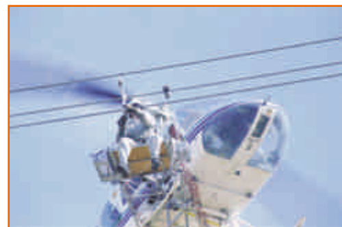
Sustitución de unos separadores de cables desde una plataforma adosada al helicóptero.
