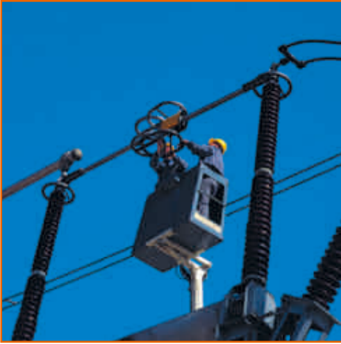
Limpieza de los contactos de un seccionador.
