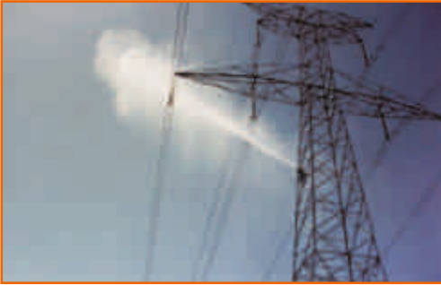
Lavado de aisladores con camión.
