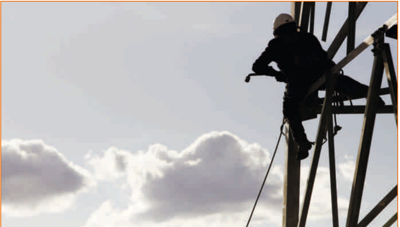
Operario realizando trabajos de mantenimiento en un apoyo.
