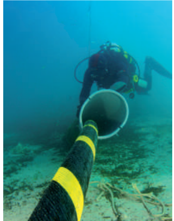
Tendido del cable submarino a su llegada a la playa de Santa Ponsa, en Mallorca
