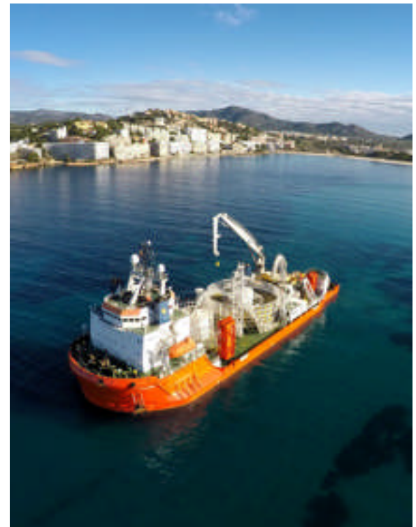
Tendido del cable submarino de la interconexión Mallorca-Ibiza
